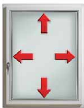
2. Steklo vstavimo v okvir in ga centriramo.
